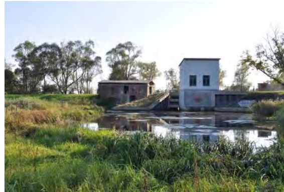
Ansicht altes und neues Schöpfwerk 2011
