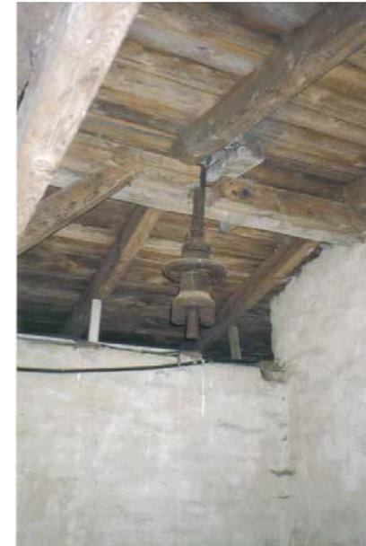
Vor der Sanierung – Die Klauenkupplung mit Antriebswelle zur Kraftübertragung im Dach – Als Geräteteil ist sie selbst noch erhalten
